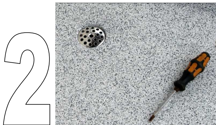
SBS - Ablaufgarnitur einlegen und verschrauben
