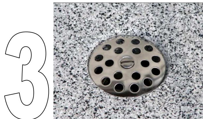
SBS - Ablaufgarnitur fertig eingebaut
